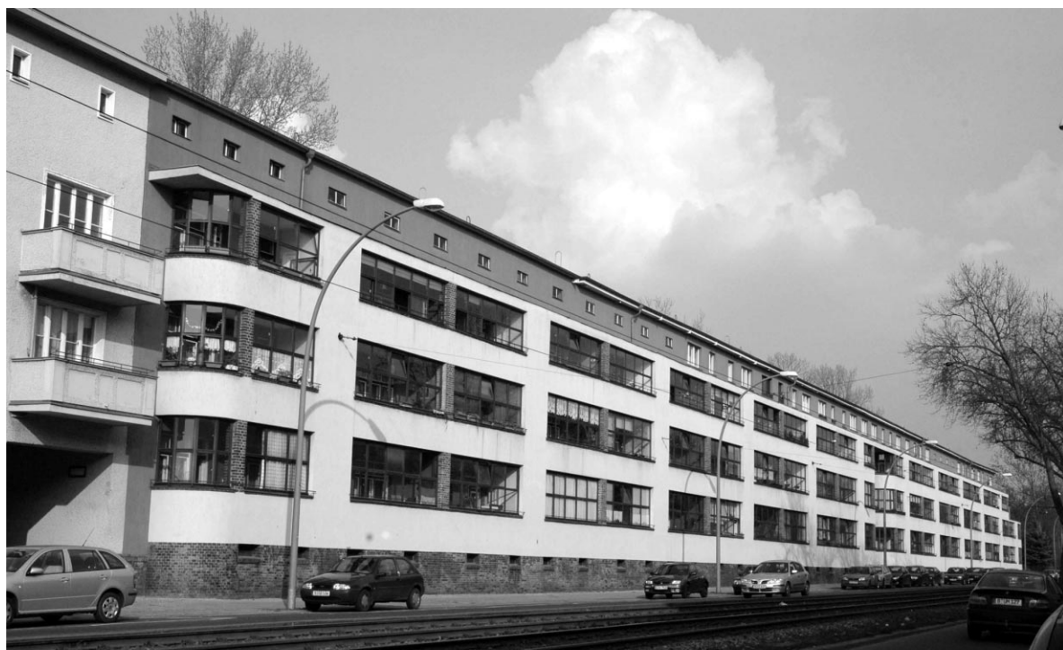
写真1 ブッシュアレーの北側道路に沿って建つ集合住宅
