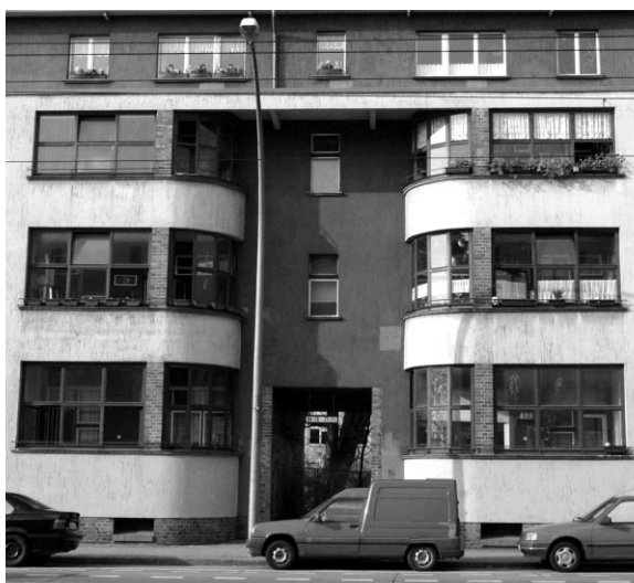
写真5 ブッシュアレーの集合住宅の道路側から中庭への通路
