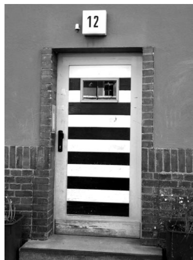
写真13 やや古くなったこの集合住宅の玄関扉
