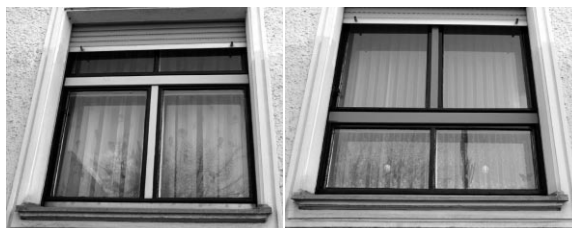
写真3 外壁窓の黄色い窓枠
