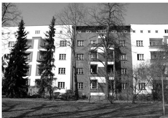
写真10 庭側から見た外壁
