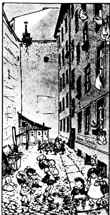
図6 第一次世界大戦後のベルリンの劣悪な集合住宅(ハインリッヒ・チレ) 2)
