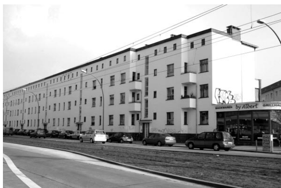
写真6 ブッシュアレーに沿った南側集合住宅の北側外壁
