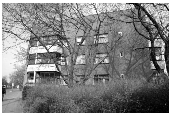
写真8 ハンザ通りに面するえび茶色に着色された集合住宅
