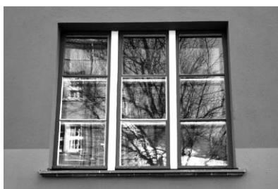
写真11 青い窓枠と青い外壁
