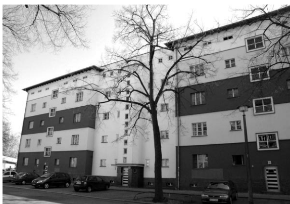
写真9 トリエラー通りに面する外壁
