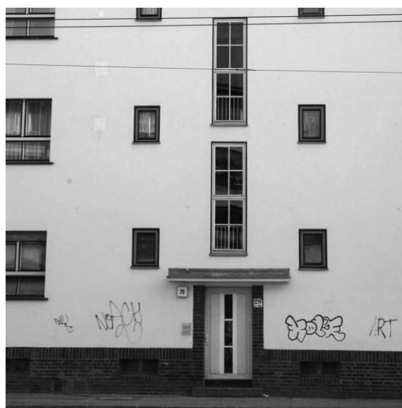
写真7 ブッシュアレー南側住宅の北側外壁にある玄関と階段室部分
