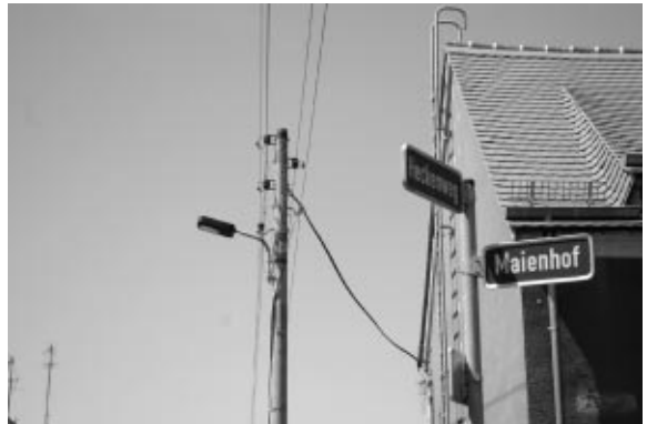
写真14 リフォームの老朽化した集合住宅と架空配線
