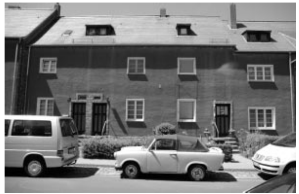
写真10 リフォルムの土色の外壁を持つ集合住宅
