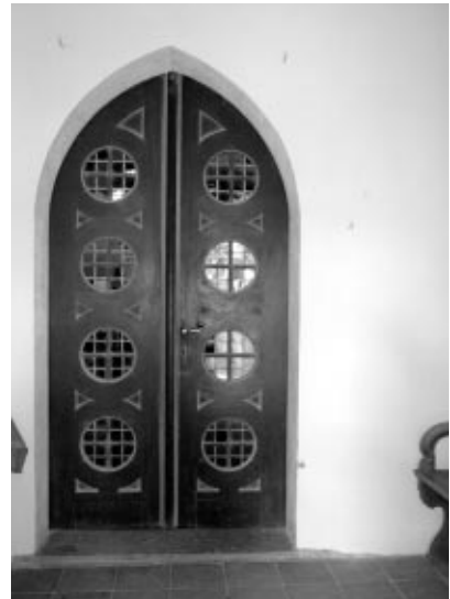
写真8 ニーデンの教会の風除け室と教会の間の扉
