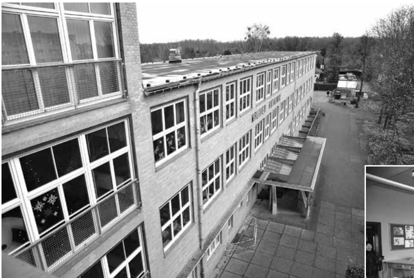
写真18 屋上は陸屋根である。(当時としては珍しい)
