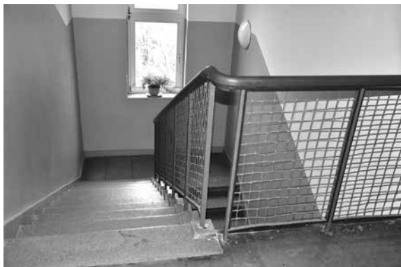
写真20 小学校階段(生徒の転落防止に網が張られている)
