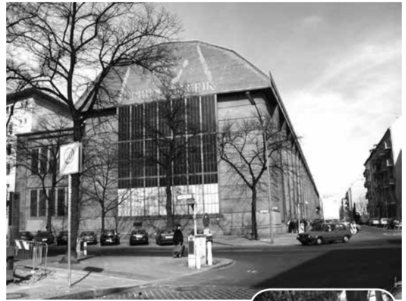
写真10 AEGタービン工場 ペーター・ペーレンス設計(1909)
