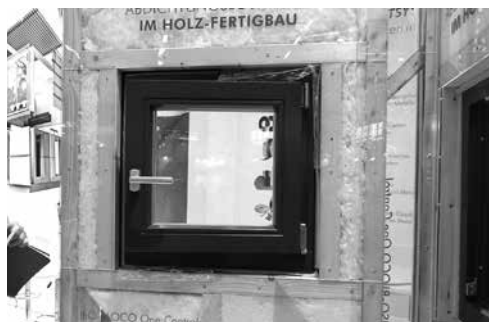
写真14 木質系プレハブ住宅の外断熱(気密性を確保した窓枠の取り付け)
