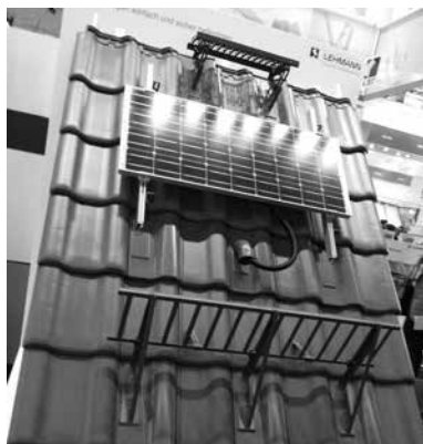
写真 28 落雪防止装置を付けた太陽電池設置の屋根
