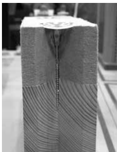
写真 30 木毛繊維断熱材を木造躯体に接合するアンカーボルト (Fischer 社)
