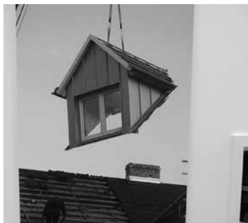
写真33 切妻屋根を持つ屋根室をプレハブ的に取り付けるデモ
