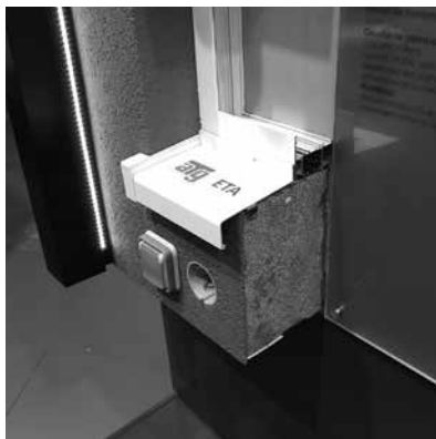
写真8 湿式外断熱の構成と窓、貫通孔の取り付け、窓の水切りの長さに注意。木毛繊維断熱材が使用されている (Sto 社)
