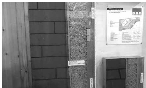
写真12 セルローズファイバー断熱材を使用した外断熱の構成 (DHD 社)
