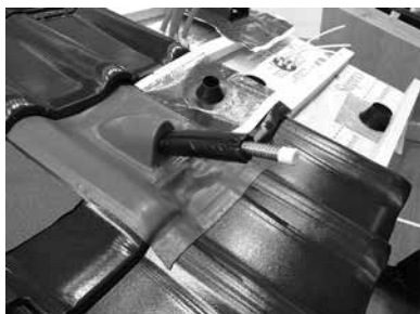
写真 27 太陽電池からの電線を取り入れる瓦 (防水対策済)
