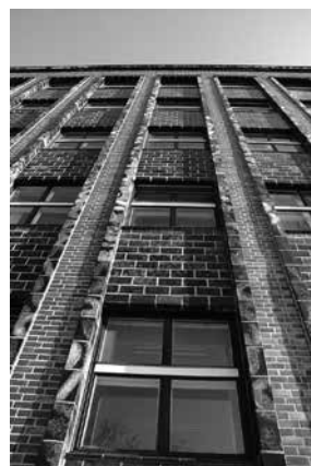
写真 19 放送局ガラス窓を含む外壁
