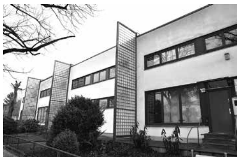
写真37 ショレマー通り 12-12C の住宅 (Schorlemer Allee 12-12C) 1988年に道路側外壁が修復された。
