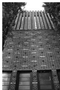
写真2 ホーエンツォレン広場教会の側壁
