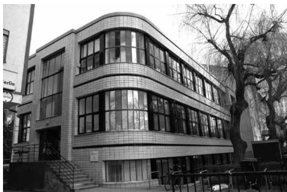
写真24 アブラハムゾン計測器会社 (Meßgerätefabrik Abrahamson)
