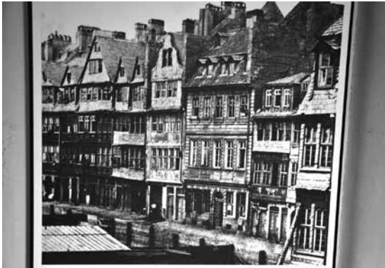
写真7 フランクフルトのユダヤ人ゲッター(フランクフルトのユダヤ博物館)
