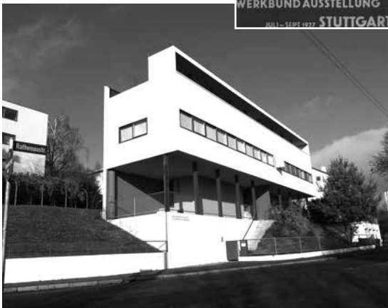
写真9 ヴァイセンホーフジードルング(Weißenhofsiedlung)に建つル・コルビジェの作品
