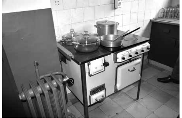
写真 19 電気式調理プレートと電気オープン
