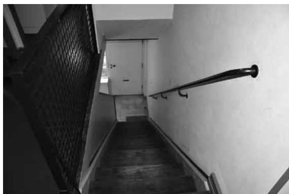
写真25 地下室へ降りる階段
