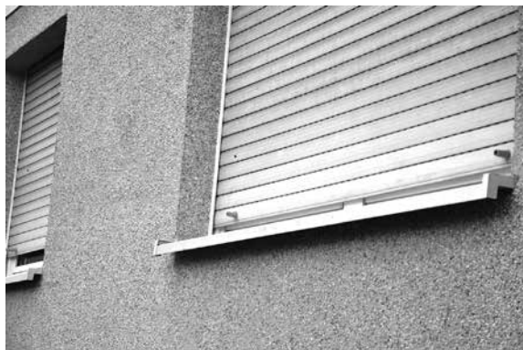
写真10 ニーダーラッドのジグザク集合住宅の窓に付けられた水切り
