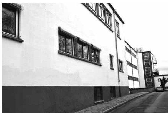
写真1 ニーダーラッドの長方形集合住宅
