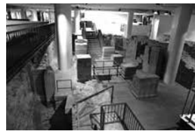
写真30 フランクフルトのユダヤ博物館、ユダヤ人ガッセの地下構造
