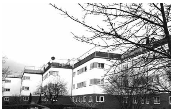
写真8 ニーダーラッドのジグザク集合住宅
