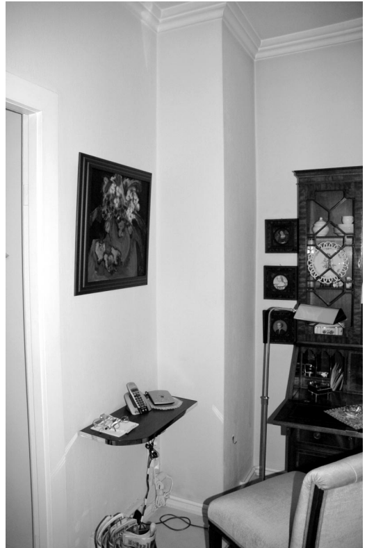
Photo 1 カッヘルオーフェンの煙道を飾り柱で使用している(オンケル・トムズ・ヒュッテの住宅)
