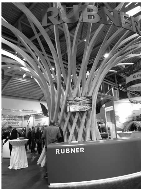
写真19 CLT(BSH)を使用した大型木造構造物
