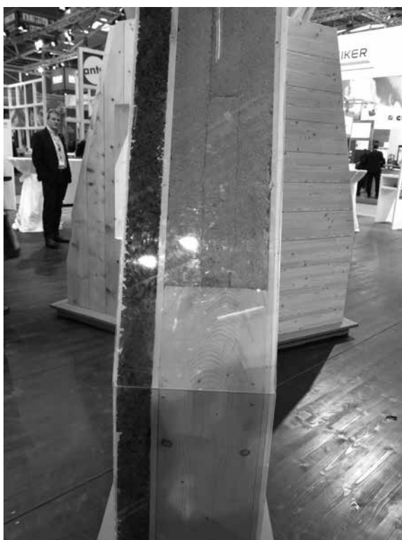
写真18 外壁の断熱構造を展示する住宅会社
