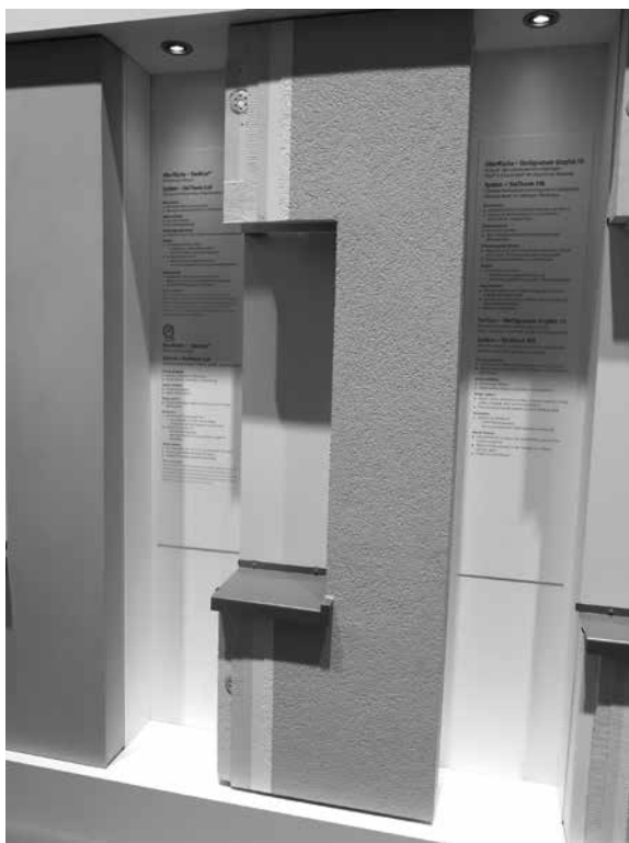
写真 24 Stö 社による湿式外断熱の構成展示
