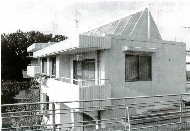
写真1 外断熱が行われ、築後23年経過し全く損傷のないソーラーハウス(東京)
