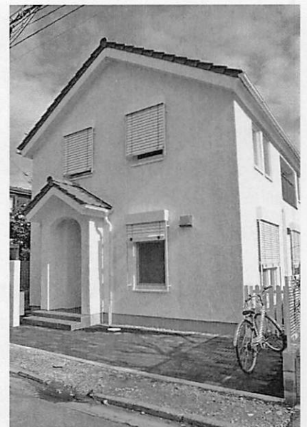
写真 25 外断熱建物には外付けブラインドが必要
