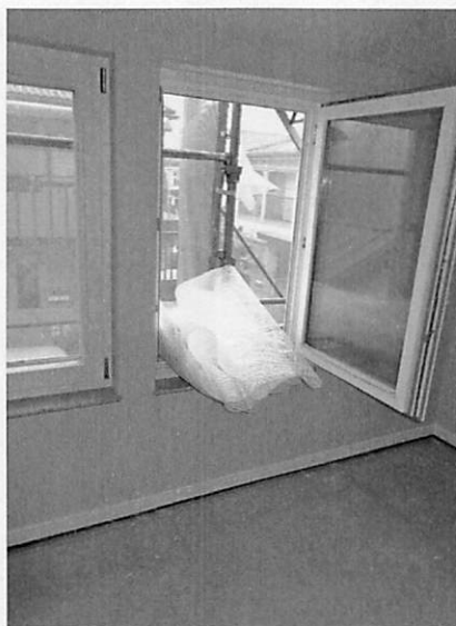
写真21 木製サッシ、3重ガラス窓の取り付け工事
