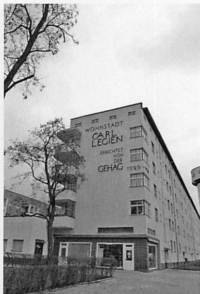
写真16 カールレギエンの集合住宅
