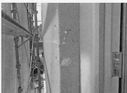
写真20 木毛繊維断熱材による外断熱工事
