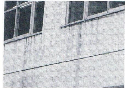
Bild 2. Verschmutzung um Fenster (Bibliothek der Ochanomizu Universität). Dicht wachsende Mikroorganismen vermischen sich mit Roststaub unter dem Fensterrahmen.
