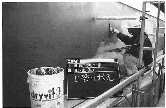
Bild 9. Das Armierungsgewebe in die mit Klebemörtel vollständig geputzte und eingebettete Wandfläche, dient zum Verfestigen der Platten.
