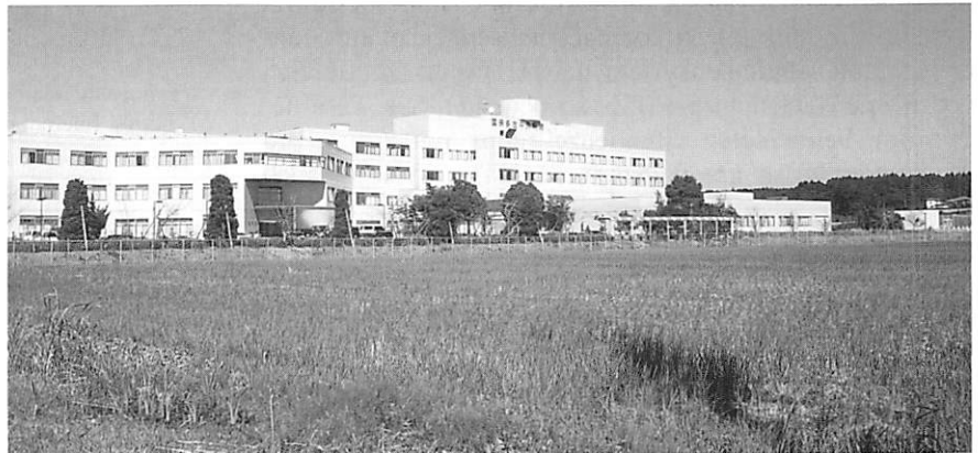
Bild 1. T-Krankenhaus in Chiba mit außenseitiger Wärmedämmung.
