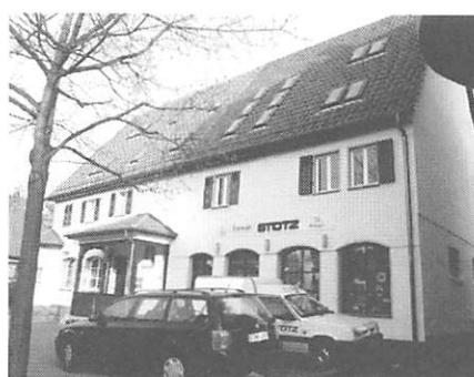
写真12 Stuttgart Vaihingerstr.の老朽化したレストラン兼事務所建築の外断熱改修竣工（平成14年3月撮影）
