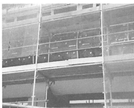
写真22 Berlin市Ernst ReuterplatzにおけるIBM事務所建築の外断熱改修（平成13年10月撮影）ロックウールがジベルで取り付けられている。
