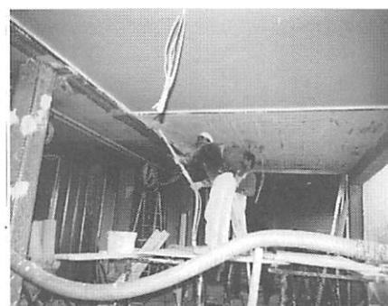
写真35 ポリプロピレン配管を天井に接着モルタルを使用して埋め込む (Berlin市Steglitzの事務所建築)
