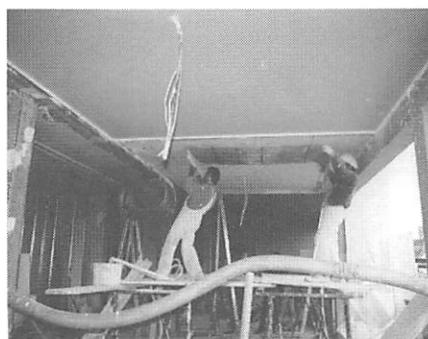
写真34 ポリプロピレン配管を天井に接着モルタルを使用して埋め込む (Berlin市Steglitzの事務所建築)
