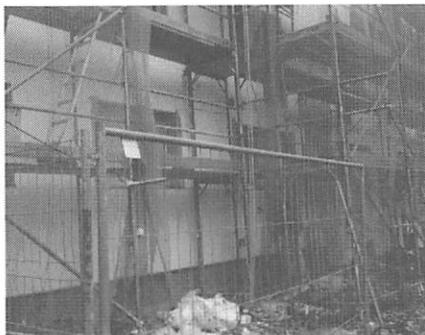
写真15 Berlin市 Heiligenndammerstr.の集合住宅の外断熱改修工事 (平成13年10月撮影)
