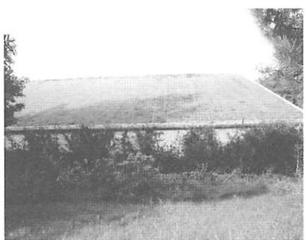
写真37 ベルリン郊外の体育館の屋根を植栽することにより断熱改修を行った例
