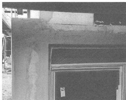
写真7 Stuttgart Jurastr.事務所建築における外断熱工事における窓周りの収まり（隅部分はグラスファイバーメッシュによる特別の補強が行われる）
