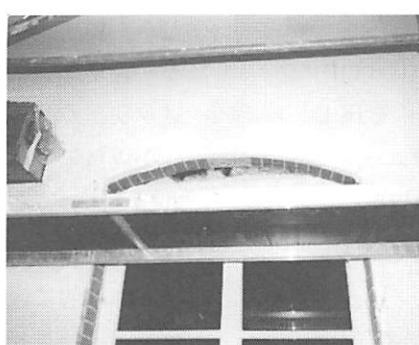
写真10 Stuttgart Vaihingerstr.の老朽化したレストラン兼事務所建築の外断熱改修（円形部分は職人が現場で発泡スチレンを加工）（平成13年10月撮影）
