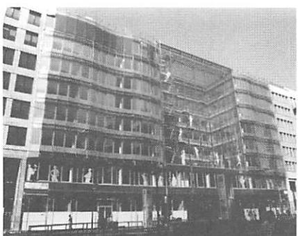
写真24 旧東ベルリンのFriedrichstr.の事務所建築における外断熱改修
