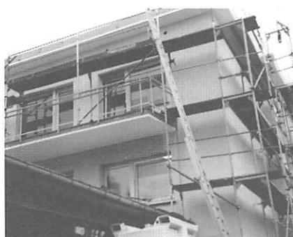
写真13 Stuttgart Wallgrabenの塗装業者ビルの外断熱改修工事（平成13年10月撮影）
