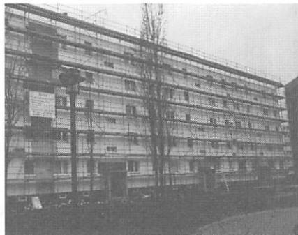
写真30 ベルリン市郊外の集合住宅外断熱改修
