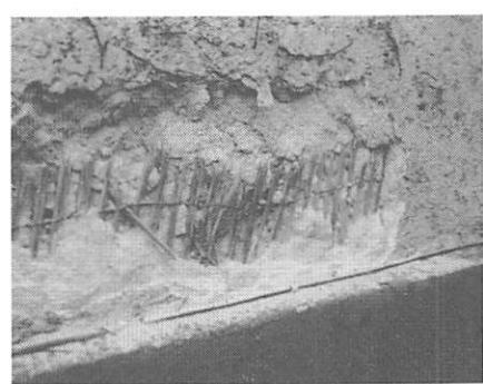
写真11 Stuttgart Vaihingerstr.の老朽化したレストラン兼事務所建築の外断熱改修（外壁はい草が見えるまでに老朽化している）（平成13年10月撮影）
