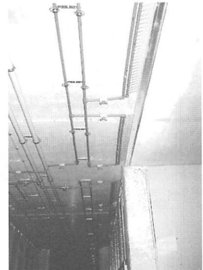
写真36 ポリプロピレン配管を天井に埋め込み天井放射冷暖房を行う改修工事 (Berlin市Steglitzの事務所建築)廊下側にヘッダーがある。
