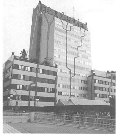
写真14 ウィーンの 地域暖房プラ ントの煙突
