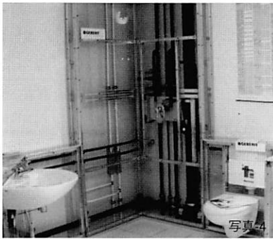
写真-4、5 | 住宅展示では壁体内の配管を見せている。
