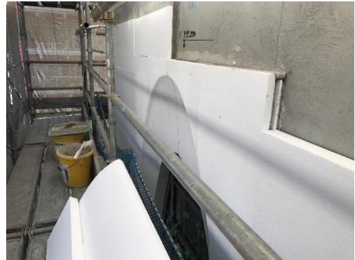
写真-13 EPS (50mm) の貼り付け、九段小学校
