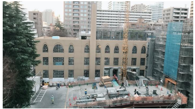
写真-12 千代田区立九段小学校外断熱改修
