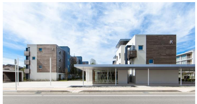
写真-14 富山県黒部のパッシブタウン 3 ブロック J 棟の外断熱改修（写真 YKK 不動産） 1)
