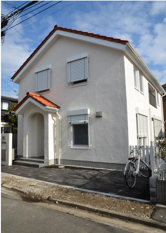
写真-11 外ブラインドを設置した外断熱住宅
