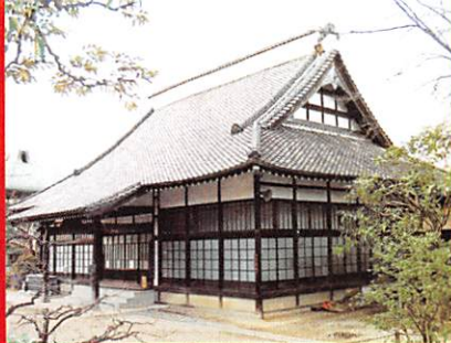
タウトの改造計画に基づいて改修された当時の大講堂（1960）
