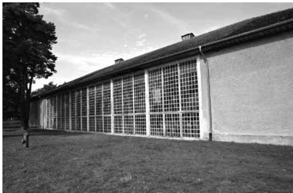
写真19 屋内プールの外壁にはガラスブロックが嵌め込まれている
