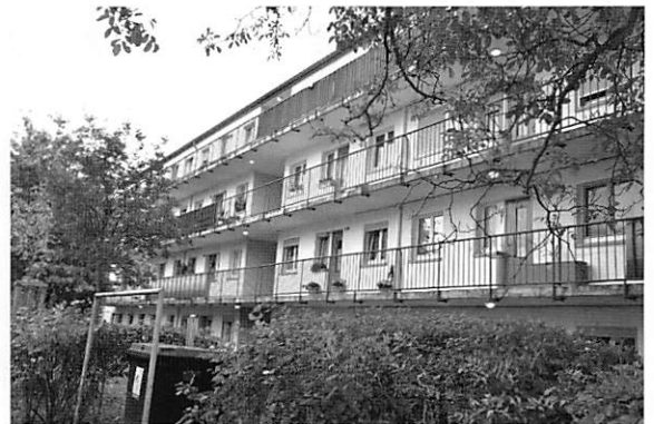
写真4 1955～57年に建設された4階建集合住宅
