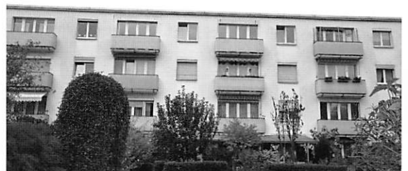
写真5 1955～57年に建設された4階建集合住宅
