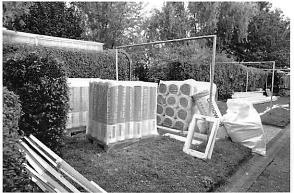
写真9 住棟前に並ぶ改修に使用される建材
