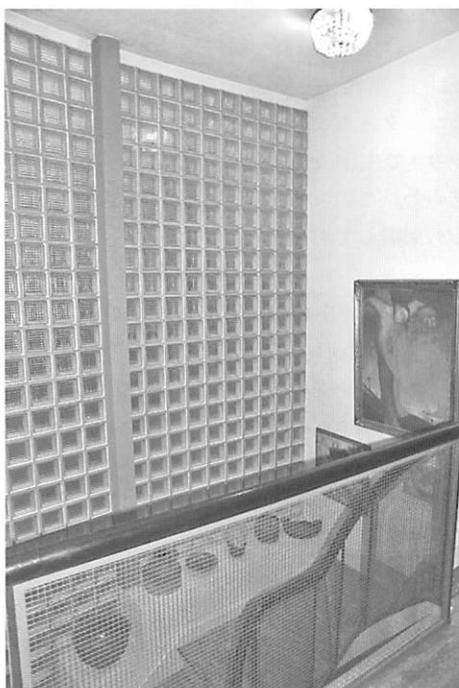
写真14 タウト旧宅階段と外壁のガラスブロック
