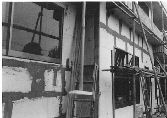
写真4 筆者自宅の外断熱工事(1980年)
