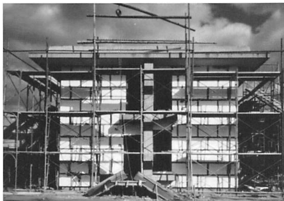
写真3 サンシャイン計画における湿式外断熱(1977年)
