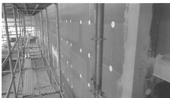
写真7 黒部ホテルアクアの外断熱工事
