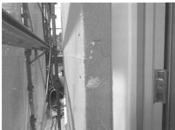
写真5 木毛繊維断熱板で外断熱を行った武蔵野市の小住宅
