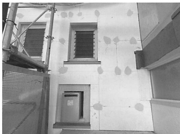
写真6 千葉県花見川団地における外断熱改修工事(2021年)
