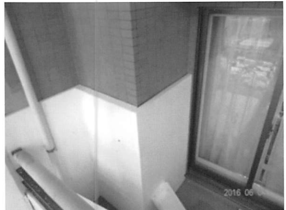
写真7 (カルム円山) 所在地:札幌市中央区、竣工:2001年、構造: SRC造14階建て、塔屋1階、住戸数26戸、設計:大橋建築 設計室、施工:StoJapan
