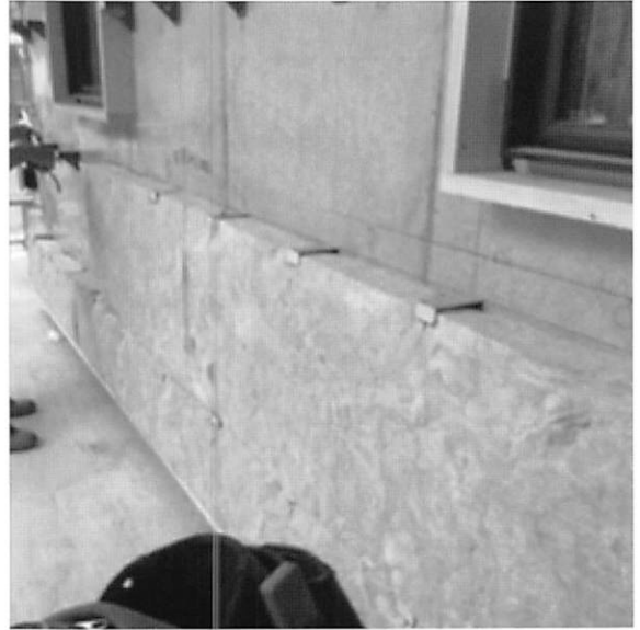
写真5 (長野県軽井沢町の住宅) 竣工:2021年11月、構造:1階 はRC造、2階は木造の混構造、延べ床面積:400㎡、設計: 林建築設計室、施工:守屋商会、断熱施工:信越ビーアイビー
