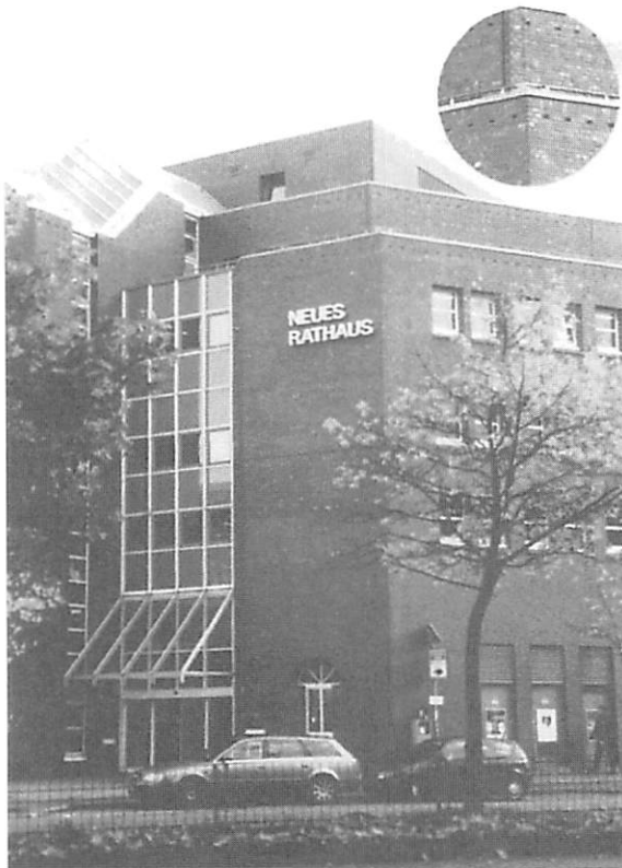
図 58 DIN 1053-1(1996)に準拠した換気口を持つキールの新市庁舎。最も強い雨荷重は建物の最上部で発生する。換気によって除去されるよりも多くの雨が上部の開口部から侵入することが、試験[68]によって確認されている。
