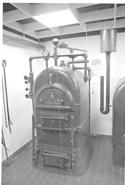
図-12 博物館所蔵最古のボイラ、米国製鑄鉄製セクショナルボイラ(ブデルス社暖房博物館所蔵)
