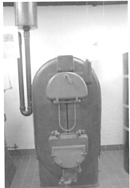
図-16 Strebel社製の鋳鉄製セクショナルボイラ (ブデルス社暖房博物館所蔵)
