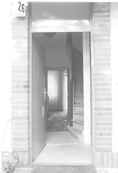
写真-4 煙突効果を利用した自然換気のための急な階段
