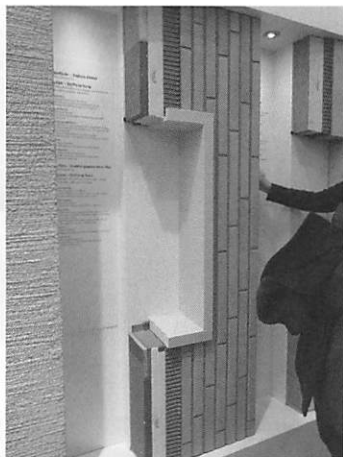
写真-7 Sto社のタイルで仕上げた湿式外断熱工法
