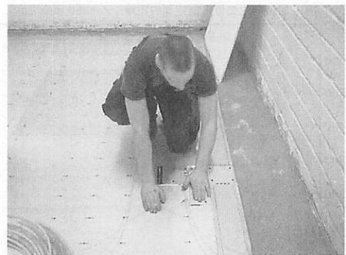
写真-9 ドイツでも施工されるようになった日本の乾式床暖房, Fremdwärmenutzungsgradがよいとして最近注目を浴びている。
