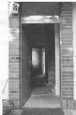
写真-6 庭側の扉との通風、および階段の煙突効果を利用した通風 (Waldsiedlung Onkel Toms Hütte)
