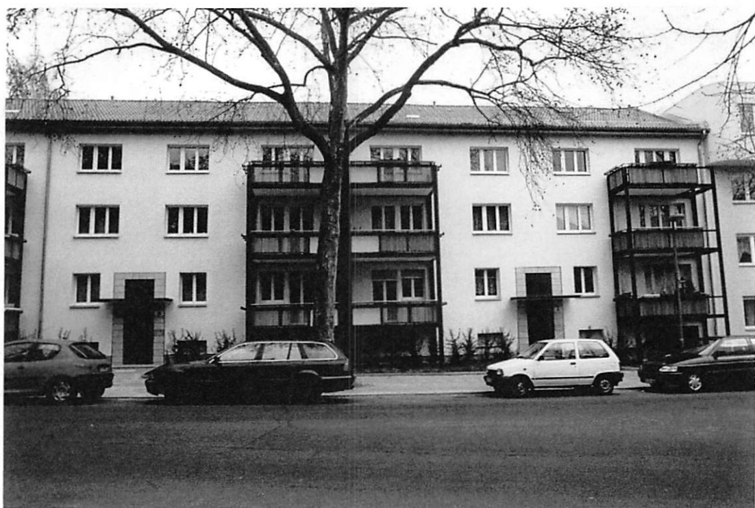
写-18 Berlin市 Heiligendammerstr.の集合住宅外断熱改修工事竣工写真(平成14年3)
