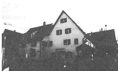
図一 13 Stuttgart, Vaingerstr.のレストラン兼事務所の外断熱改修
