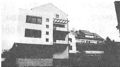
図一 9 StuttgartのJurastr.事務所建築の外断熱改修
