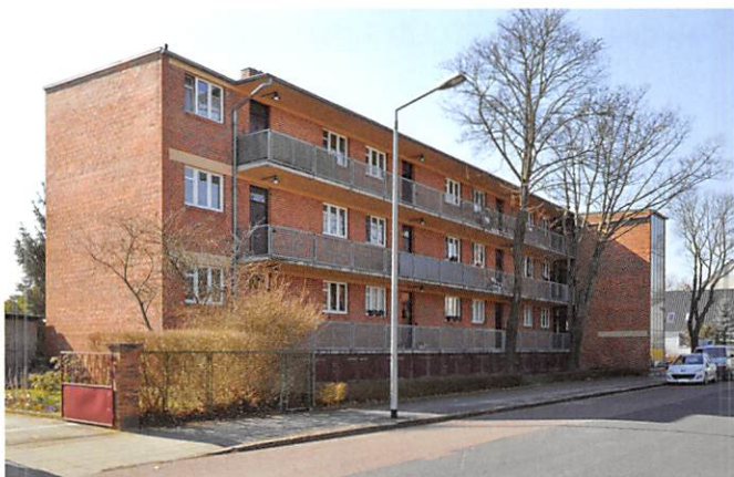
③ ヴァルター・グロピウス設計の片廊下型集合住宅(デッサウ、テルテン)。(撮影:筆者)
