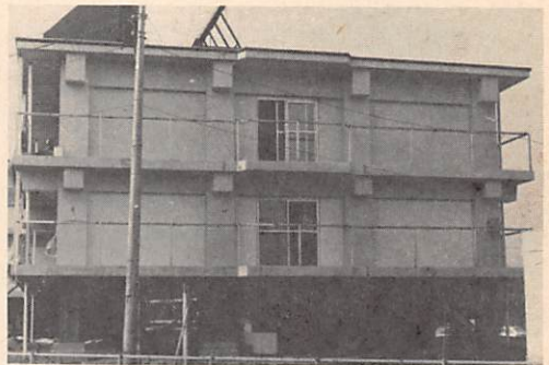
第9図 工事後の外壁
