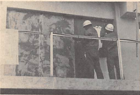
第6図 グラスファイバーメッシュの張り付け
