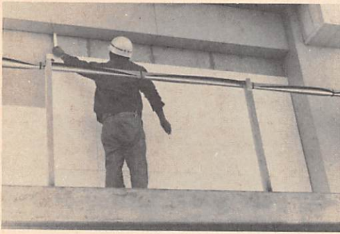
第4図 スチロロール板貼付
