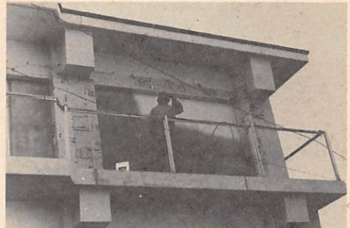
第8図 ラオザン吹き付けによる仕上げ
