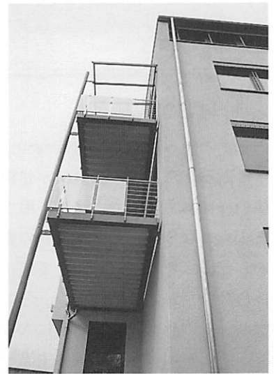
写真5 Stuttgart 市内 Jurastr.の事務所建築における湿式外断熱工事
