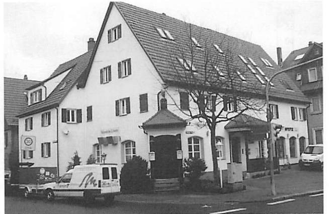
写真7 Stuttgart 市内 Vaihingerstr.のレストラン兼事務所建築における湿式外断熱工事竣工
