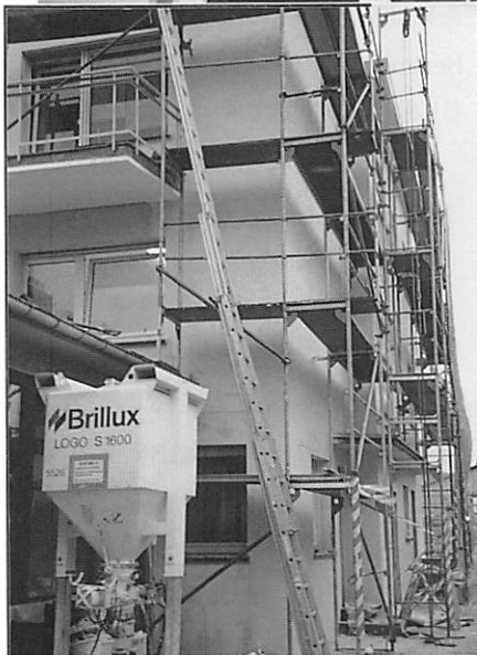
写真8 Stuttgart 市内 Wallgraben.の塗装店事務所建築における湿式外断熱工事
