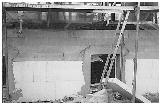
写真1 Stuttgart市内Jurastr.の事務所建築における湿式外断熱工事
