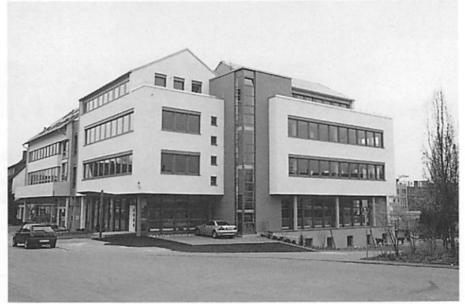
写真3 Stuttgart 市内 Jurastr.の事務所建築における湿式外断熱工事
