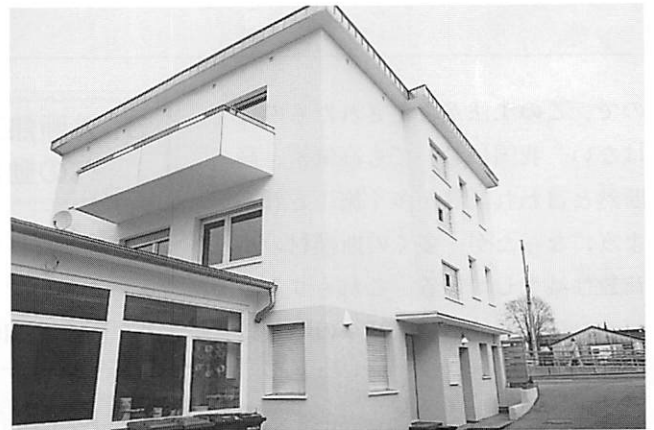
写真9 Stuttgart 市内 Wallgraben.の塗装店事務所建築における湿式外断熱工事竣工
