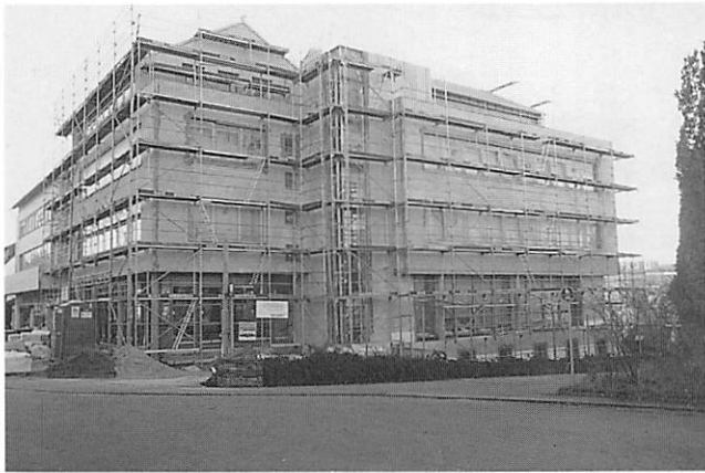
写真2 Stuttgart 市内 Jurastr.の事務所建築における湿式外断熱工事
