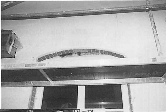
写真6 Stuttgart 市内 Vaihingerstr.のレストラン兼事務所建築における湿式外断熱工事
