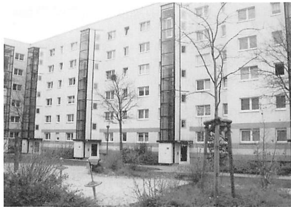
写真3 旧東ベルリンで外断熱改修が修了した集合住宅
