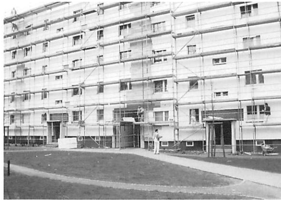
写真2 旧東ベルリンで外断熱改修を行う集合住宅
