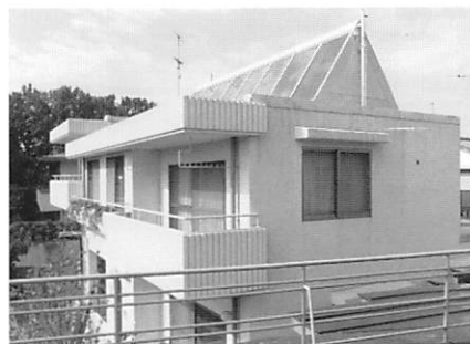
写真1 外断熱工法を施したソーラーハウス
