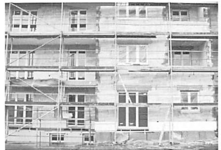
写真7 ミュンヘン郊外の集合住宅の外断熱改修工事。地盤に近い部分では押出発泡スチレンが、上部では硬質ロックウール板が使用されている。
