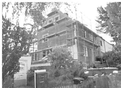
写真18 ブルーノ・タウトが1920年代に設計した住宅は現在も使用されている。ただし、省エネルギーの観点から湿式外断熱工法が施されている。
