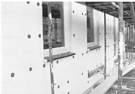
写真5 ミュンヘン郊外の住宅における外断熱改修工事 発泡スチレン取り付けにジベルが使用される
