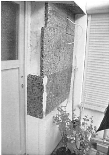
写真8 既設の住宅にコルクを貼り、外断熱施工を実施。
