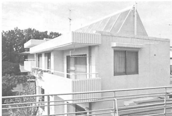
写真2 東京都杉並の全面的に外断熱工事を施した田中ソーラーハウス。築後25年になるが全く損傷もなく快適な生活が送られている。
