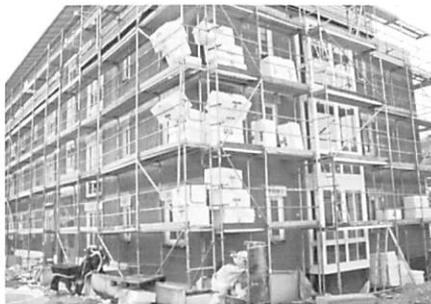
写真6 ミュンヘン郊外の集合住宅における外断熱改修（断熱材は外断熱協会の認定品が使用されている）
