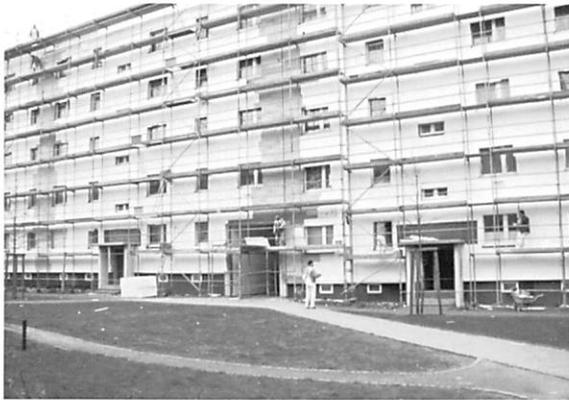
写真3 旧東ベルリンにおける集合住宅の外断熱改修工事
