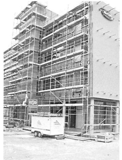
写真4 ミュンヘンのFrankfurteringにおける外断熱改修（夏季対策に外付けブラインドが設置される）
