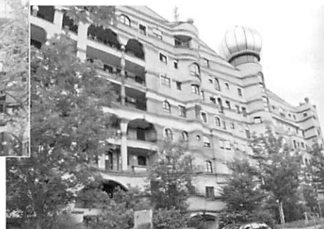
写真13 ドイツダルムシュタットのフンデルトバッサーハウスも外断熱が施されている。
