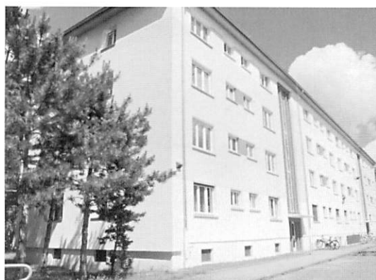
写真9 ブルーノ・タウト設計の住宅も外断熱改修が行われている
