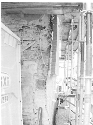
写真10 外断熱改修が行われるウルムの古い建物
