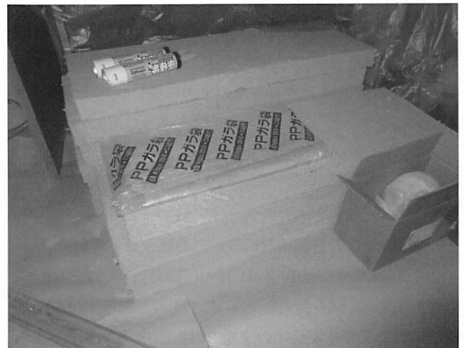
写真3 内断熱工事に使用された軟質木毛繊維断熱材料
