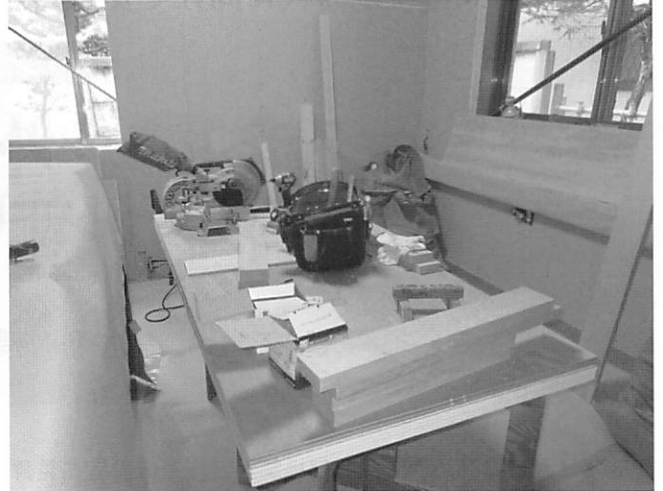
写真2 省エネルギー改修のための木毛繊維断熱材で内断熱工事
