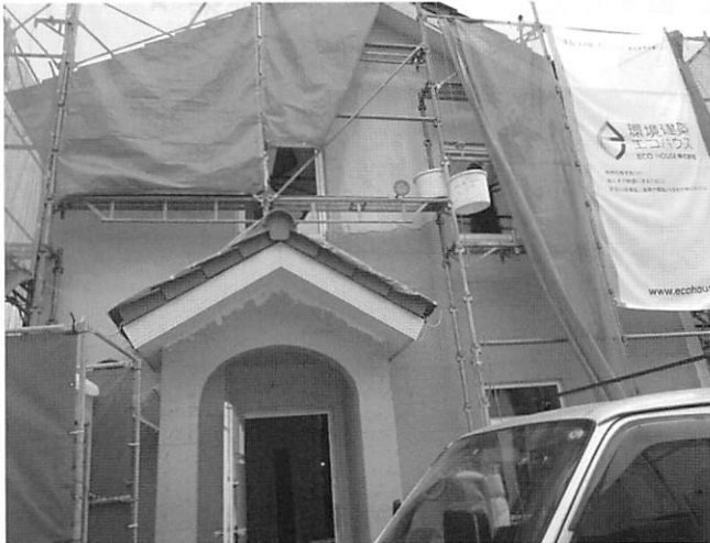
写真1 高断熱、高気密住宅の木毛繊維断熱材による外断熱工事
