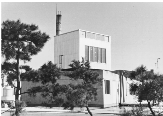
写真1 大林組技術研究所の回転式空調実験室（昭和40年）
