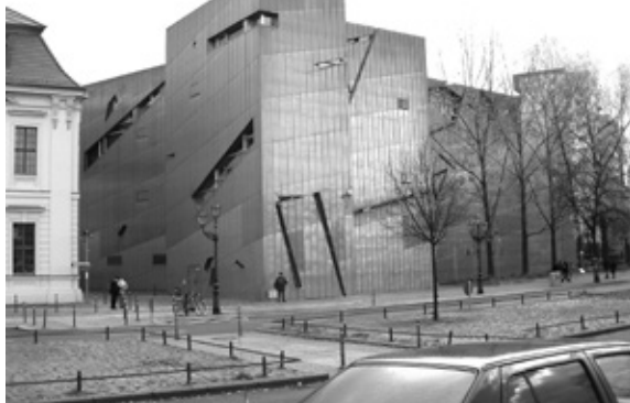
写真22 ベルリンのユダヤ博物館(リベスキント設計) 所在地：Lindenstraße 9-14, 10969 Berlin
