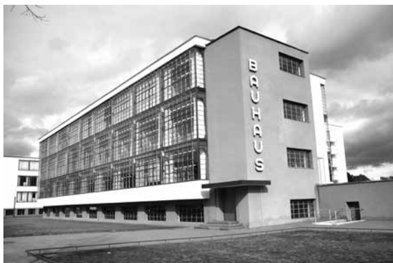
写真1 デッサウ・バウハウス、工房棟、南西面
