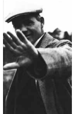
図16 1927年全ドイツ労働組合総同盟研修学校建設現場を視察するハンネス・マイヤー 4)
