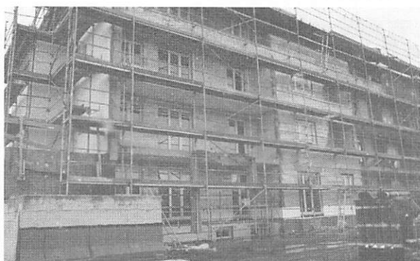
写-5 ミュンヘンの集合住宅における通気層の無い外断熱工事
