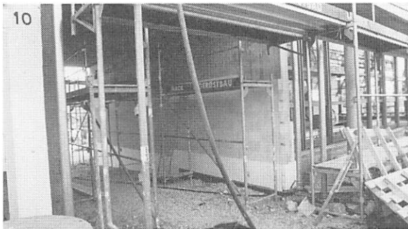
写-7 シュツットガルトにおける事務所建築の外断熱工事
