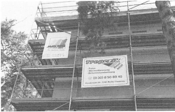
写-6 ベルリンの集合住宅における外断熱工事
