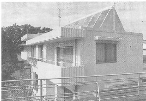
写-1 東京杉並の全面的に外断熱を施した田中ソーラーハウス。築後25年になるが全く損傷もなく、快適な生活が送られている。
