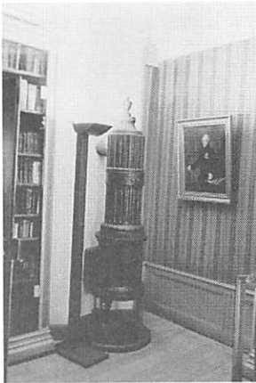
写21 ゲーテハウス所蔵の鑄鉄製放熱器 (Frankfurt.M) 放熱量の調整が出来る
