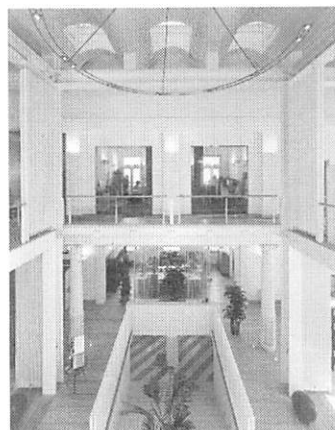
写48 熊本の事務所建築で使用された放射冷暖房用放熱器
