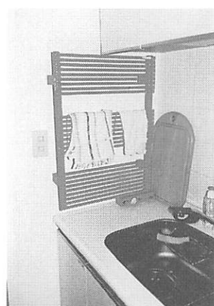
写44 ナプキンの乾燥にも使用できる厨房の放熱器 (電気式)
