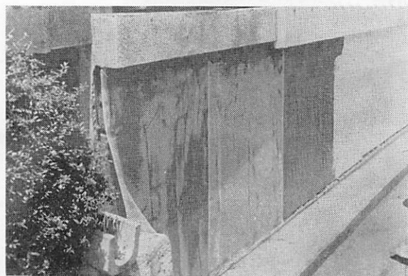
写真 11 グラスファイバーメッシュ張付け (継目は10cm重ねて張る)
