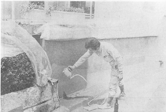
写真 13 リシン吹付による仕上げ
