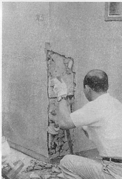
◀写真6 既存の外断熱の撤去
