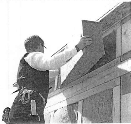
木質繊維断熱材の施工の様子
