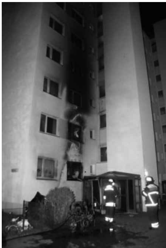
写真5 3階までのガラス窓が破壊され室内へ煙が入り、重傷者を出した。
