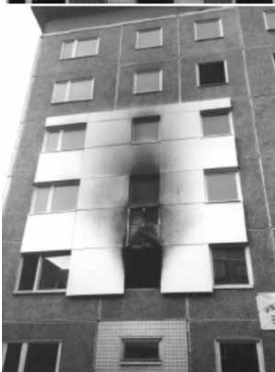
写真11 通気層のある外断熱を施した建築物での火災実験
