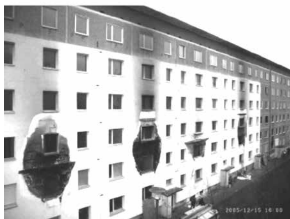
写真12 湿式外断熱を施した集合住宅の火災実験
