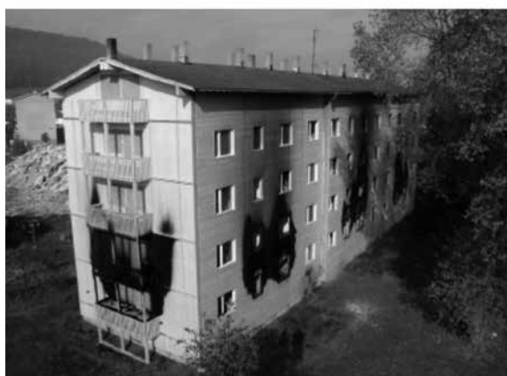
写真13 木造集合住宅での火災実験
