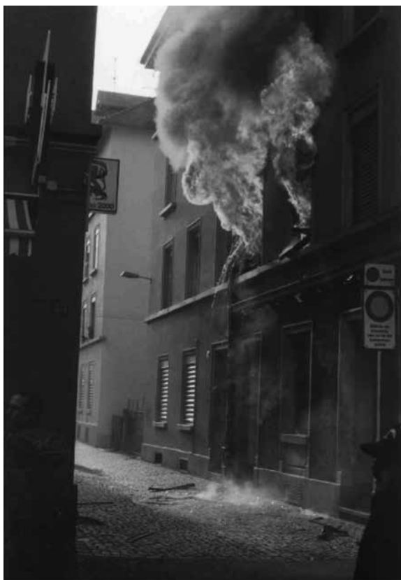
写真3 室内で発生した火災が窓ガラスを破り屋外へ及んだ例
