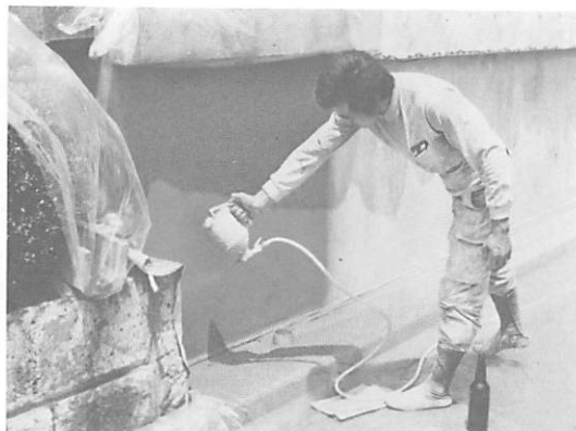
写真-12 モルタルの色を着色リシンを吹き付けて仕上げる
