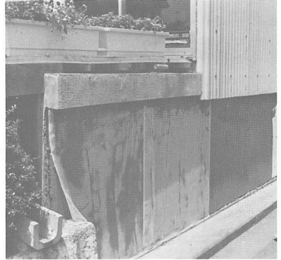
写真-9 表面の亀裂防止のためグラスファイバーメッシュを貼る
