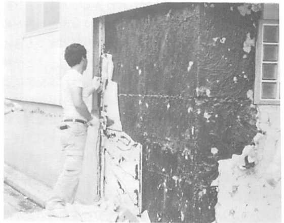
写真-3 既設の外断熱の撤去作業
