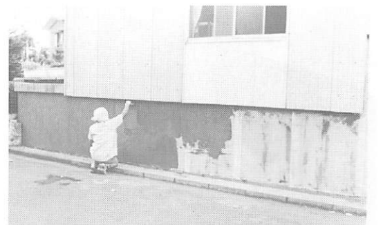
写真-11 グラスファイバーメッシュの上に2mm厚さのモルタルを塗る
