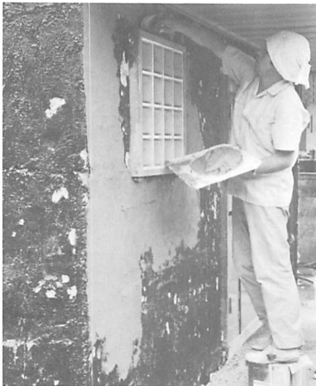
写真-4 躯体を平坦にするためのモルタル塗り
