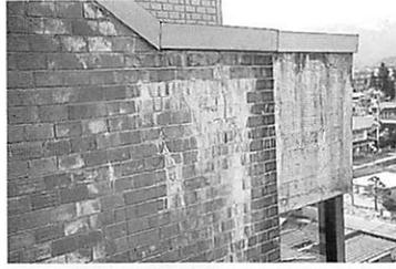
写真3 外壁の損傷が著しい部分もあった
