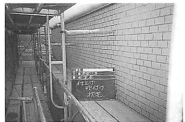
写真13 外断熱の上にテンプレートを貼り工事完了(テンプレートは外の水が内側に入らず、室内の水蒸気を外に逃す薄いタイル)
