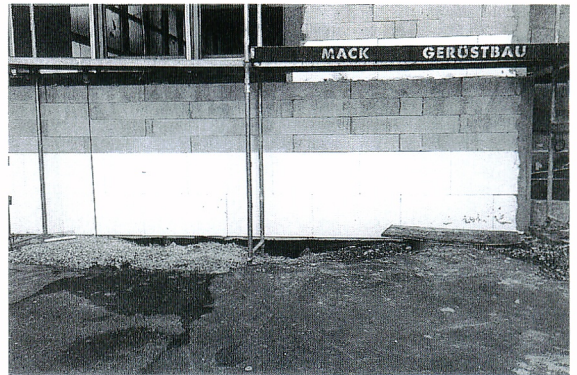
写真6 StuttgartのJurastr. 所在の事務所建築外断熱工事 (押し出し発泡スチレン、ビーズ発泡スチレン、ロックウール板が使い分けられている)
