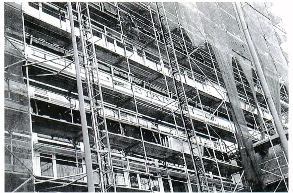
写真19 Berlin市におけるIBM社の外断熱工事（ロックウールを断熱材として使用）（平成13年10月撮影）
