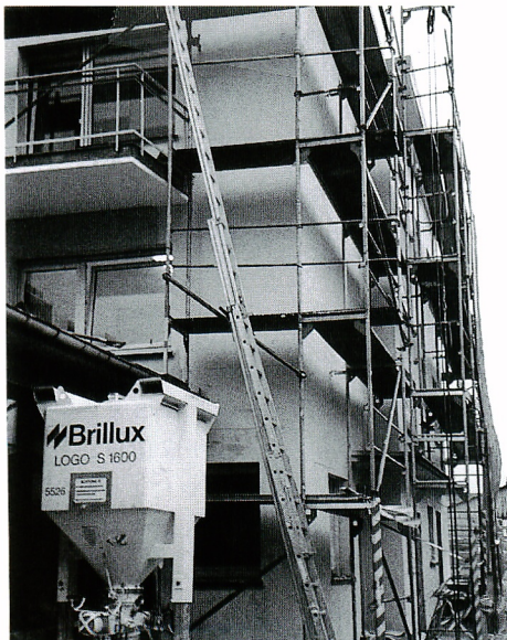
写真15 StuttgartのWallgrabenにある塗装会社のビルの外断熱改修(平成13年10月撮影)
