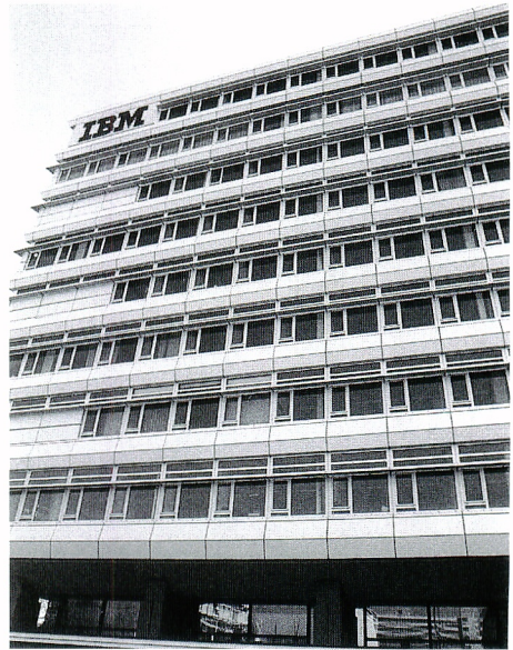
写真20 Berlin市におけるIBM社の外断熱工事後の竣工（平成14年3月撮影）
