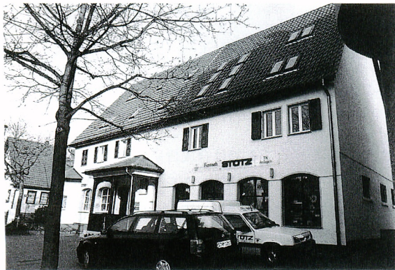
写真14 StuttgartのVaihingerstr.にある老朽化したレストラン兼事務所の外断熱工事(平成14年3月竣工時に撮影)
