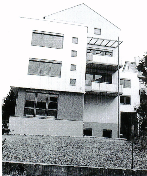
写真10 StuttgartのJurastr. 所在の事務所建築外断熱工事竣工
