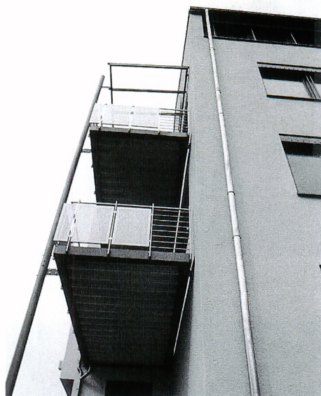
写真11 StuttgartのJurastr. 所在の事務所建築外断熱工事 (バルコニー部分は熱的に縁が切られている)
