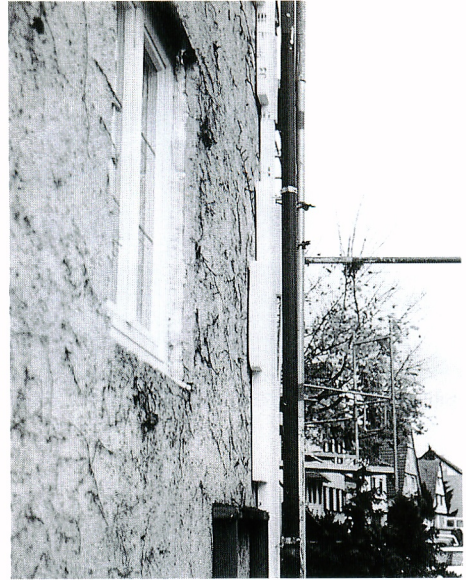
写真13 StuttgartのVaihingerstr.にある老朽化したレストラン兼事務所の外断熱工事
