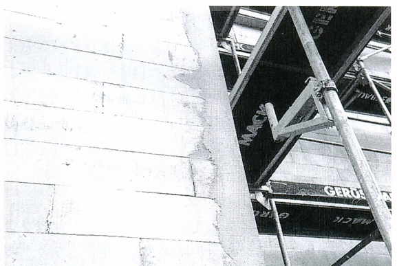
写真8 StuttgartのJurastr. 所在の事務所建築外断熱工事 (外断熱隅角部の保護)
