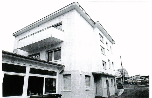
写真17 StuttgartのWallgrabenにある塗装会社のビルの外断熱改修(平成13年10月撮影)
