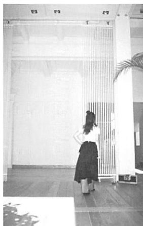
写真29 冷房も行える放熱器（熊本の事務所建築）
