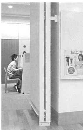
写真28 冷房も行える放熱器（茨城県ふじ代の図書館） 設計：(株)岡田新一設計事務所
