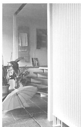
写真31 除湿・冷房も行える放熱器（代々木の事務所建築）
