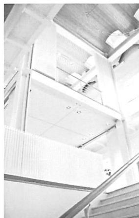
写真30 冷房も行える放熱器（熊本の事務所建築）
